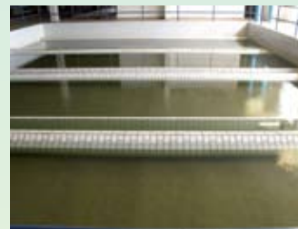
Úpravňa vody Nová Bystrica - pieskové filtre
