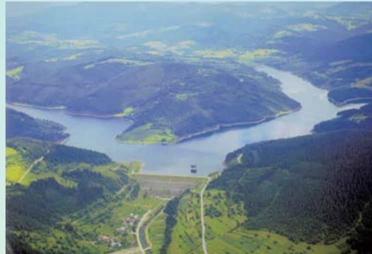
Vodárenská nádrž Nová Bystrica
