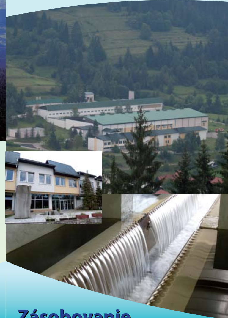
Úpravňa vody Nová Bystrica - pieskové filtre
