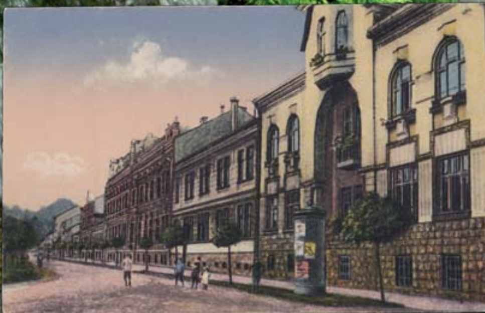
Žilina Framborská ulica
