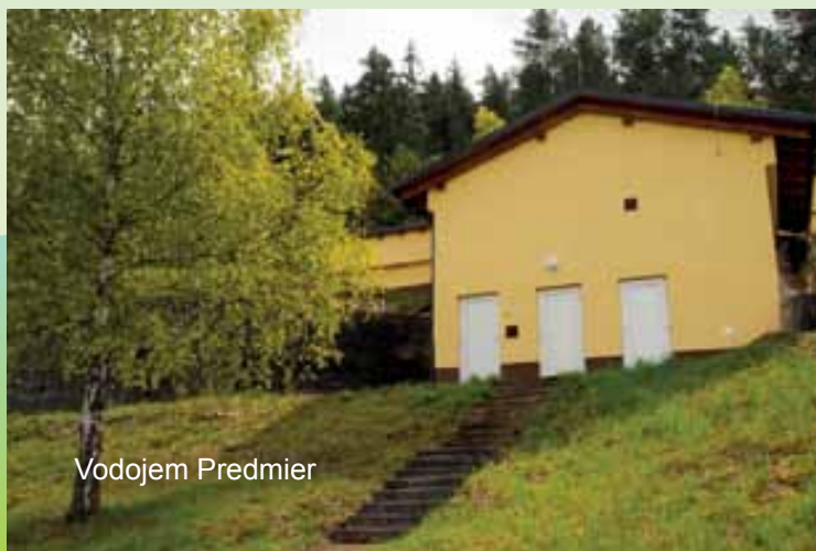
Vodárenský zdroj Bytča - Hliník
