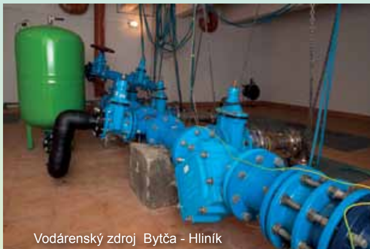
Vodárenský zdroj Bytča - Hliník
