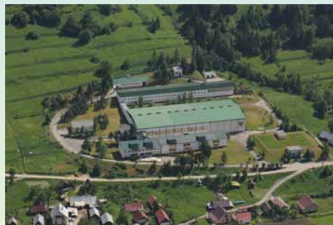
Úpravňa vody, Nová Bystrica
