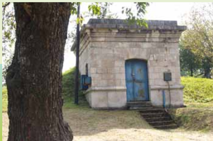
Vodojem Žilina, Bôrik
