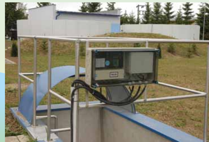
Merný objekt na odtoku - po rekonštrukcii
