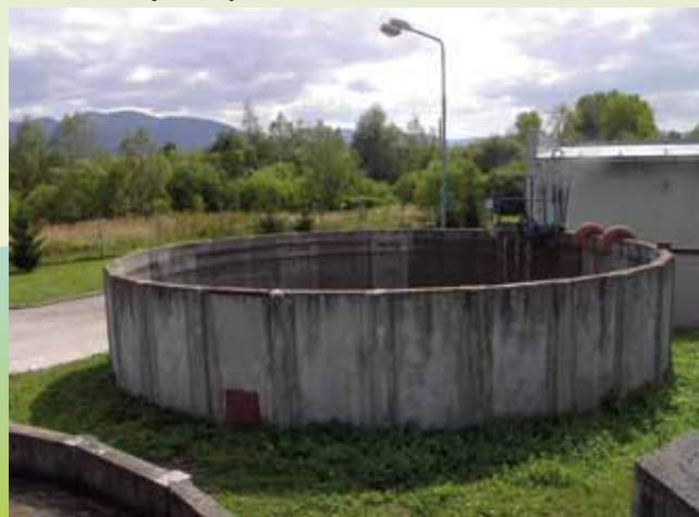
Dažďová nádrž - pred rekonštrukciou
