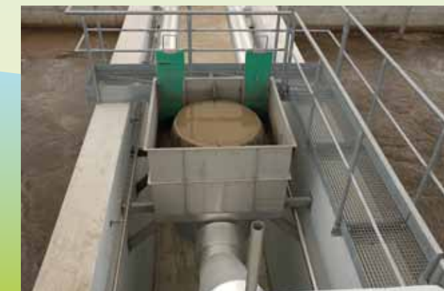
Biologický stupeň, rozdeľovací objekt - po rekonštrukcii
