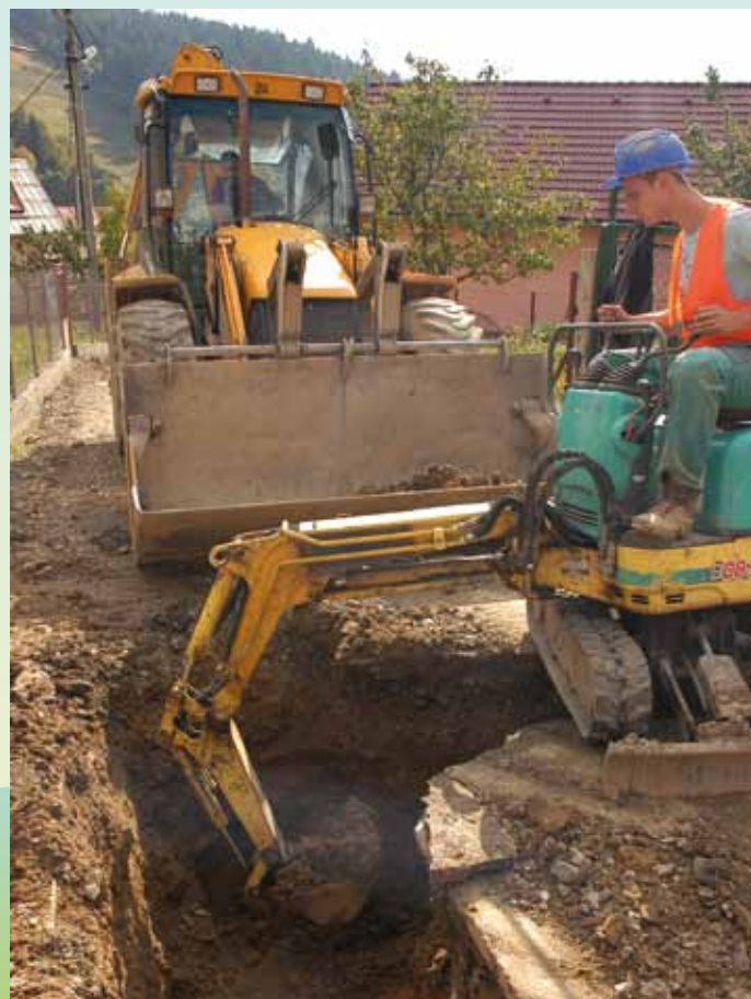
Výstavba kanalizačnej prípojky
