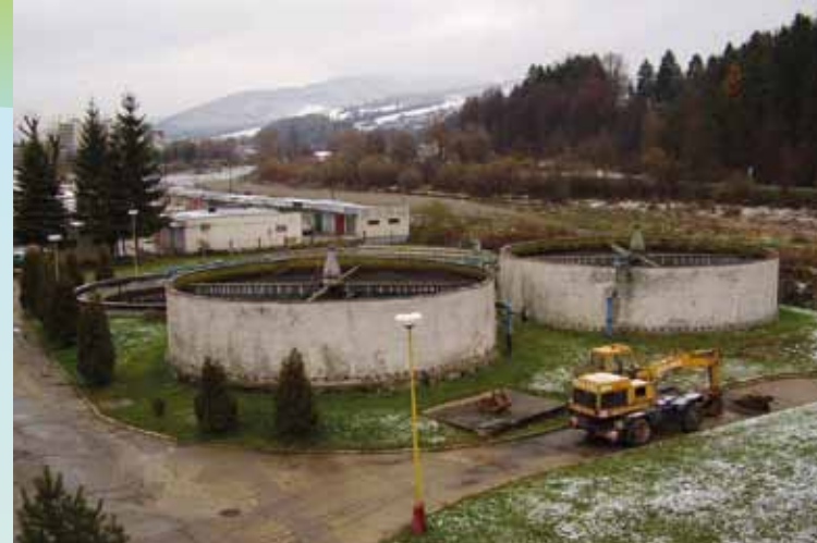
ČOV K. N. Mesto, pôvodné biofiltre
