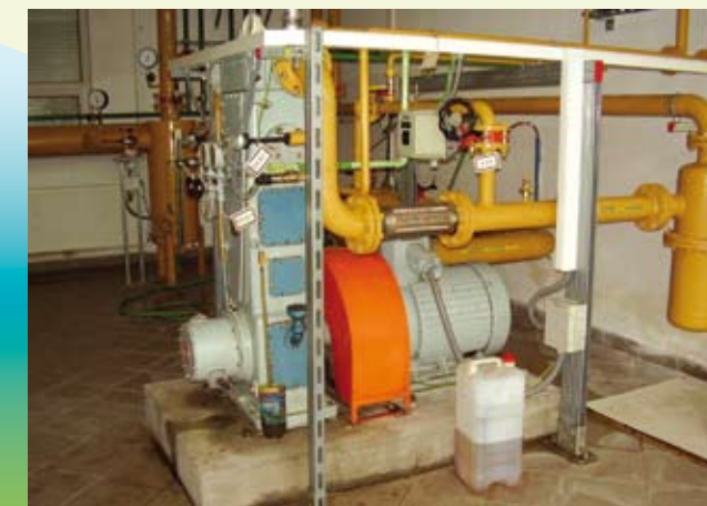
ČOV Čadca, plynový kompresor na miešanie kalu
